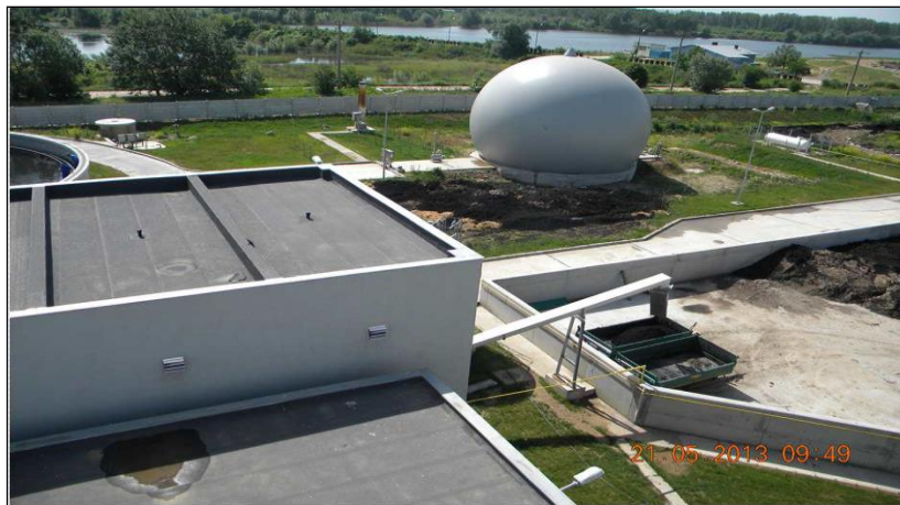
Fig.nr. 1. Stație de procesare a nămolului 68
